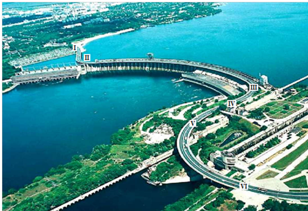
Рис. 1. Загальний вигляд автодорожнього переїзду по спорудах греблі ДніпроГЕС
